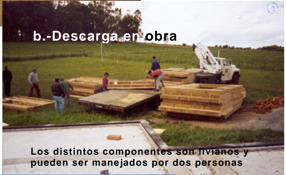
Traslado de los componentes desde la fabrica a la obra
