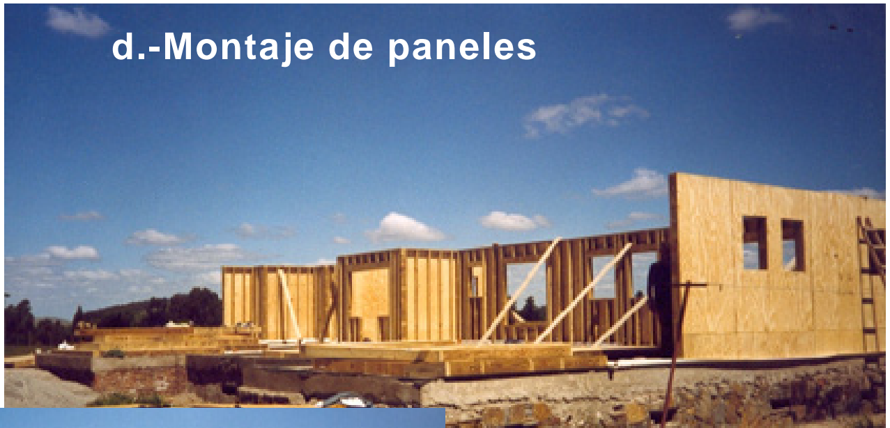
d.-Montaje de paneles
